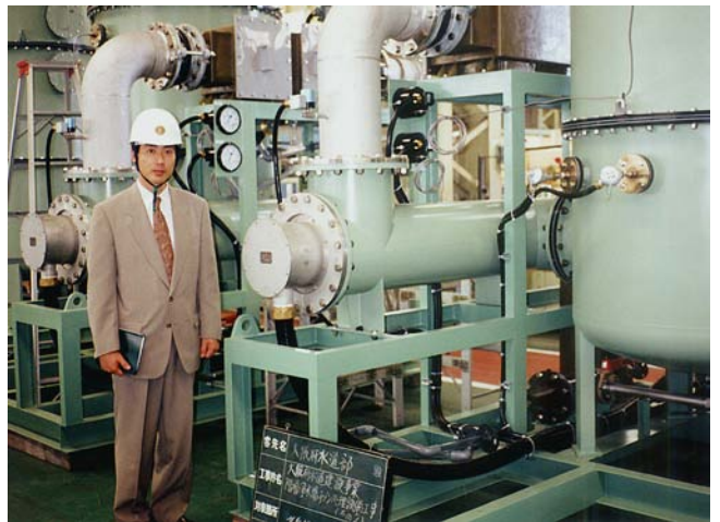
写真2 塩素ガス加熱器 ( Hastelloy )
